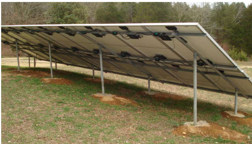
Hình 2.6: cách lắp đặt trên mặt đất
