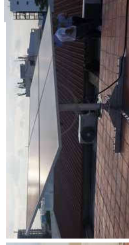
5.6 Hệ thống 2 kW cho việc nghiên cứu và phát triển hệ thống năng lượng mặt trời tại Công ty Tư Vấn Xây Dựng Điện 3 - EVN-PECC3
